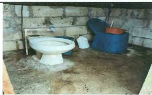
Foto 6: Mantenimiento del área de servicios sanitarios con sustitución de inodoros e instalación de lavamanos, mejoramiento de piso, repello de paredes e instalación de puerta de metal.
