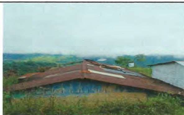
Foto 4: Sustitución de láminas de zinc y de estructura de soporte de madera ya que se encuentran en mal estado en Módulo 2.
