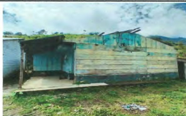
Foto 2: Remozamiento del módulo 2 con sustitución de cubierta de lámina, de estructura de techo, complemento de pared de block, mejoramiento de piso y ventanas.
